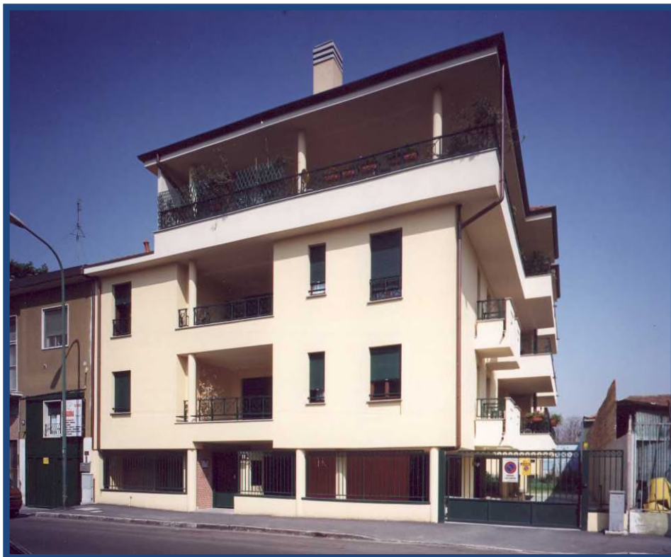
Imm.re OTTO S.R.L. Via Svevo n.11 Nuova Costruzione 1996-98 Dott. Arch. Piccoli
