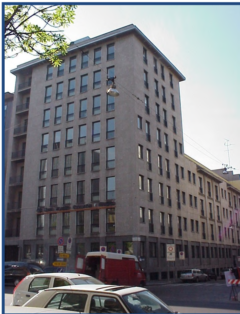
IMMOBILIARE PANDA S.R.L. Bastioni di Porta Nuova n.21 Milano Ristrutturazione intero stabile 2001-2002 Studio di Architettura Arch.ti Brivio-Tesei
