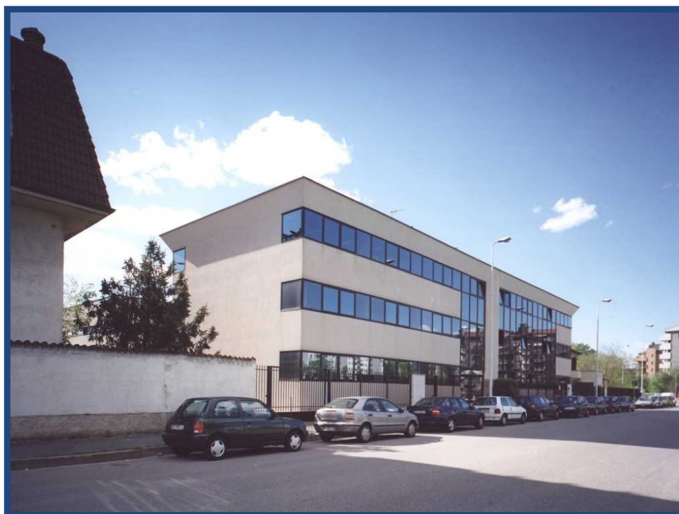
EDILLOMBARDA S.R.L. Via Pompeo Marchesi n.53/19 Milano Milano Nuova Costruzione 1988-91 Studio Architettura Bentivoglio - Brighi
