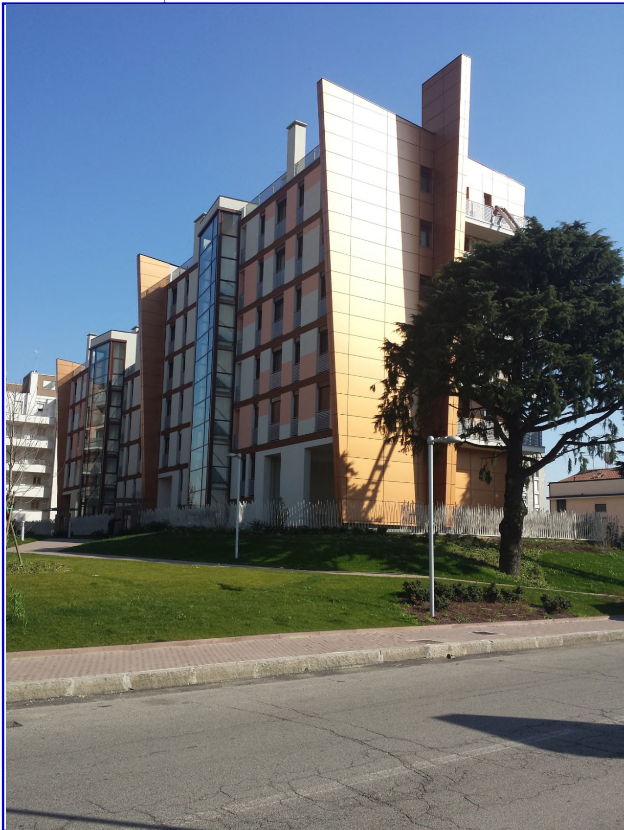
Ventonuovo Srl Complesso residenziale Buccinasco via dei Mille 2011-2014
