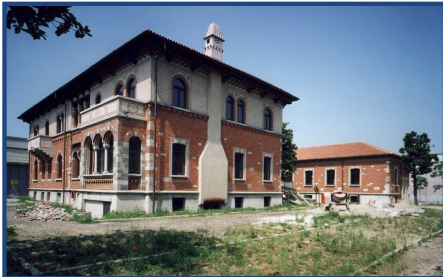
FRATELLI FAVINI Via Magenta n.77 Rho (Mi) Ristrutturazione 1997-98 Dott. Ing. Gianpaolo Bortot
