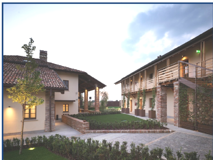
Mulino Cusago via Cisliano Ristrutturazione destinazione albergo 2008/2010
