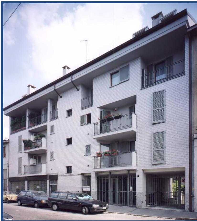
Imm.re OTTO S.R.L. Via Cesalpino n.5 Milano Nuova Costruzione con box interrati 1993-95 Dott. Arch. Zanaria
