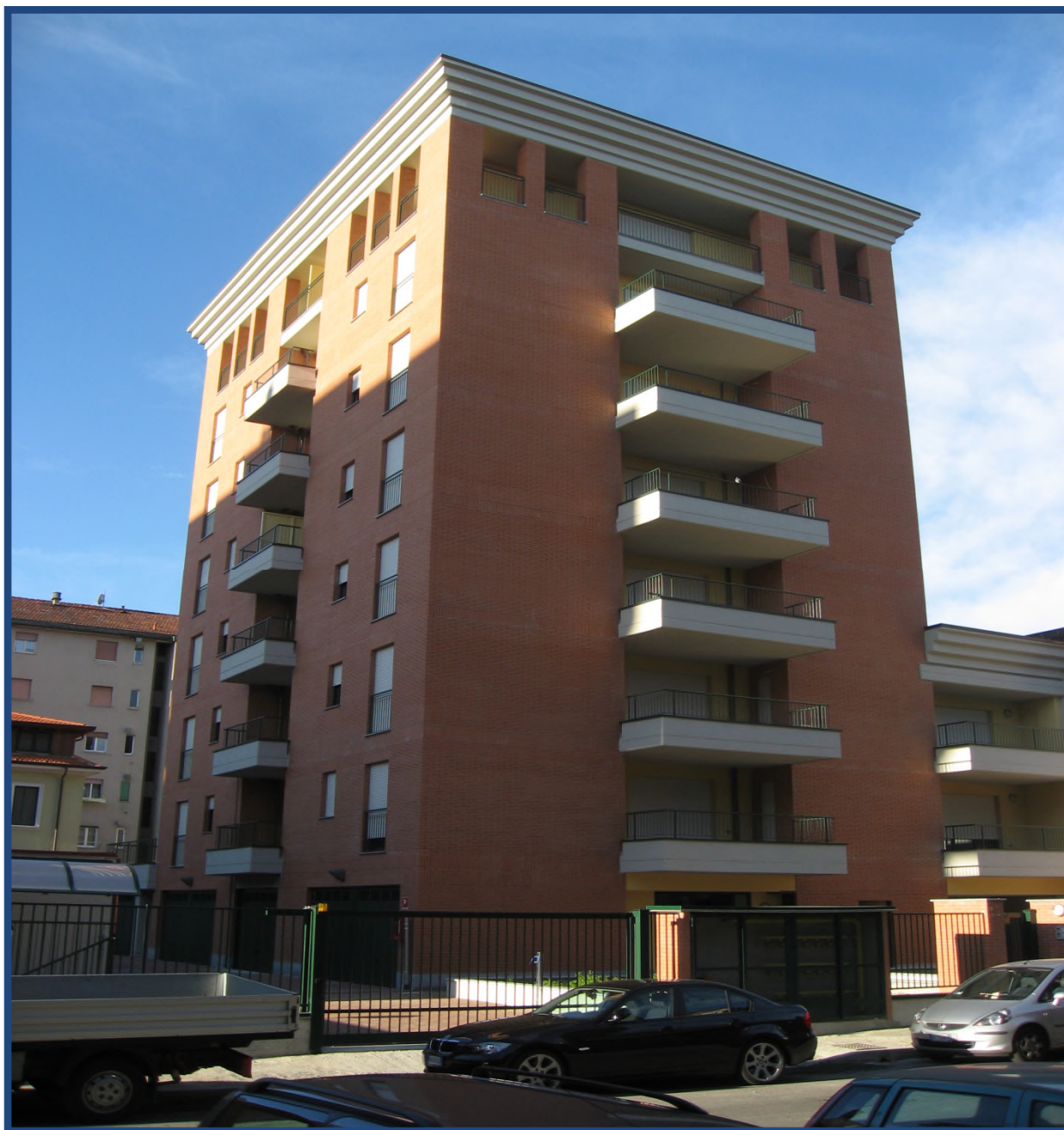
MONTE 6 S.R.L. Via Montessori n.6 Milano Nuova Costruzione 2006-2008
